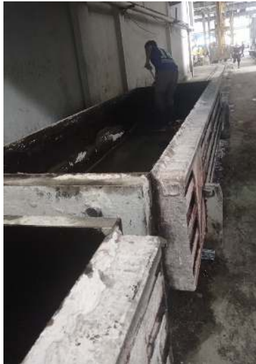
Pengolesan oli pada moulding bata ringan sebelum proses pouring
