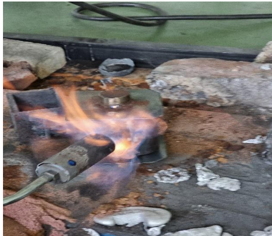
Proses pembakaran inti cor
