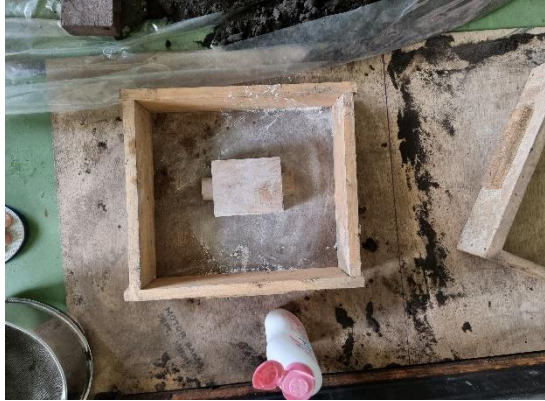
Pemasangan pola cetakan kayu
