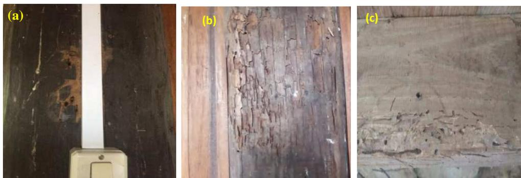
Gambar 5. Tanda dan karakteristik yang ditimbulkan oleh rayap kayu kering: (a) terdapat butiran kasar berwarna coklat pada tiang, (b) sisa lapisan permukaan kayu yang sangat tipis pada dinding, dan (c) pengeroposan pada gelagar.
