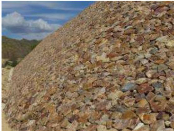
Gambar 10. Penahan dinding dengan riprap pada lereng
