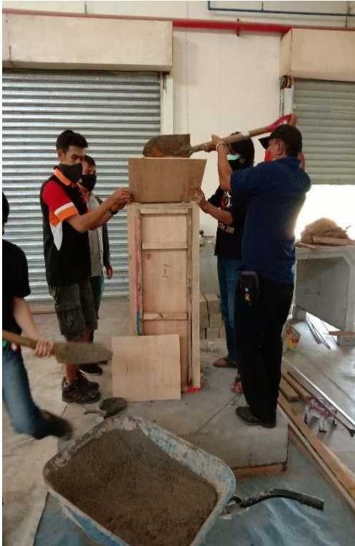
Pengecoran Retrofit
