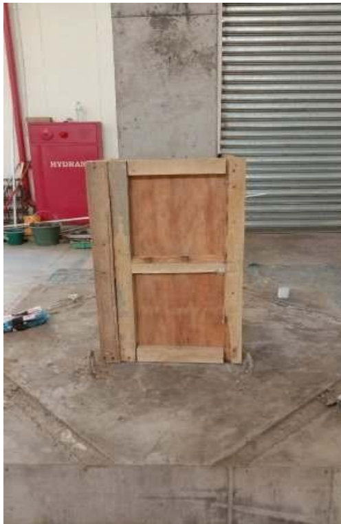
Pemasangan Wire mesh dan Bekisting Retrofit
