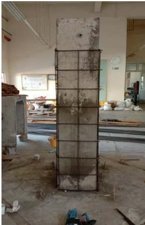
Pemasangan Wire mesh dan Bekisting Retrofit
