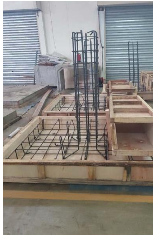
Perakitan Tulangan dan Pembuatan Bekisting
