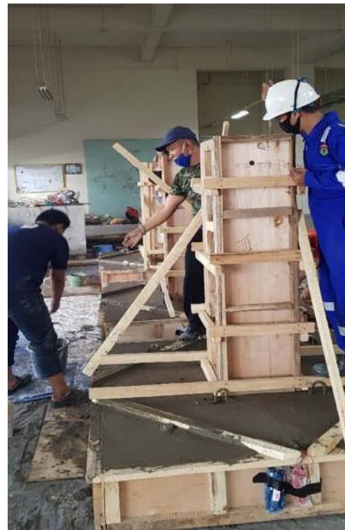
Proses Pengecoran Benda Uji
