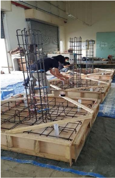
Persiapan Pengecoran
