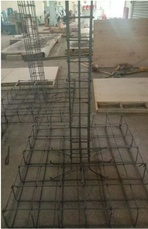
Perakitan Tulangan dan Pembuatan Bekisting
