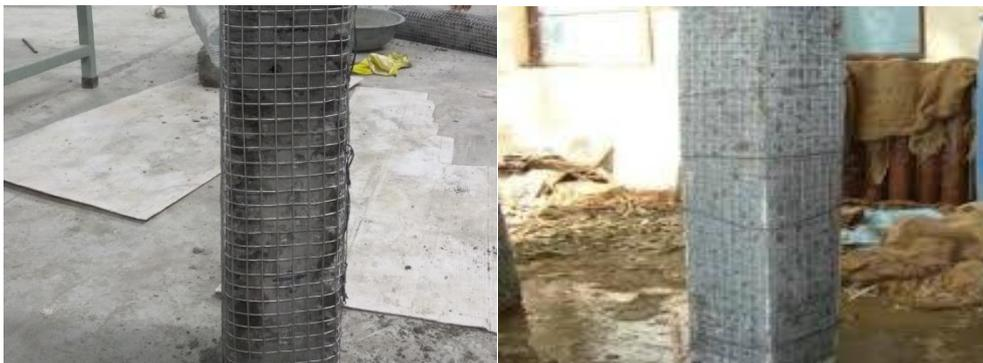
**Gambar 7.** Contoh metode *ferrocement* laminate jacketing pada kolom
