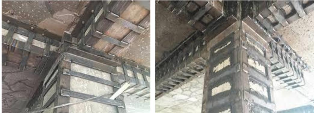
**Gambar 3.** Contoh metode *steel jacketing* pada kolom
