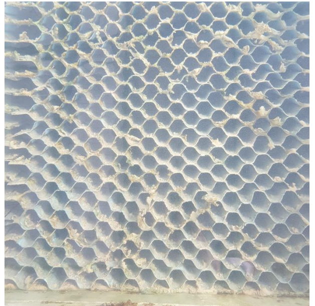
Lamella Pada Bak Unit Sedimentasi
