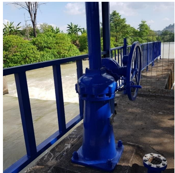
Intake Bendungan Bili-bili
