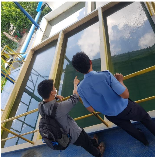
Bak Unit Filtrasi
