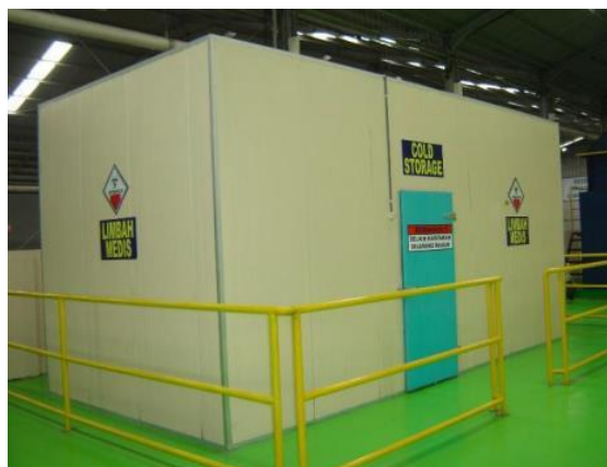
Gambar 2. Contoh ruang pendingin untuk penyimpanan limbah B3 berupa limbah medis infeksius, benda tajam, dan/atau patologis dalam waktu lebih dari 48 jam sejak limbah B3 dihasilkan.
