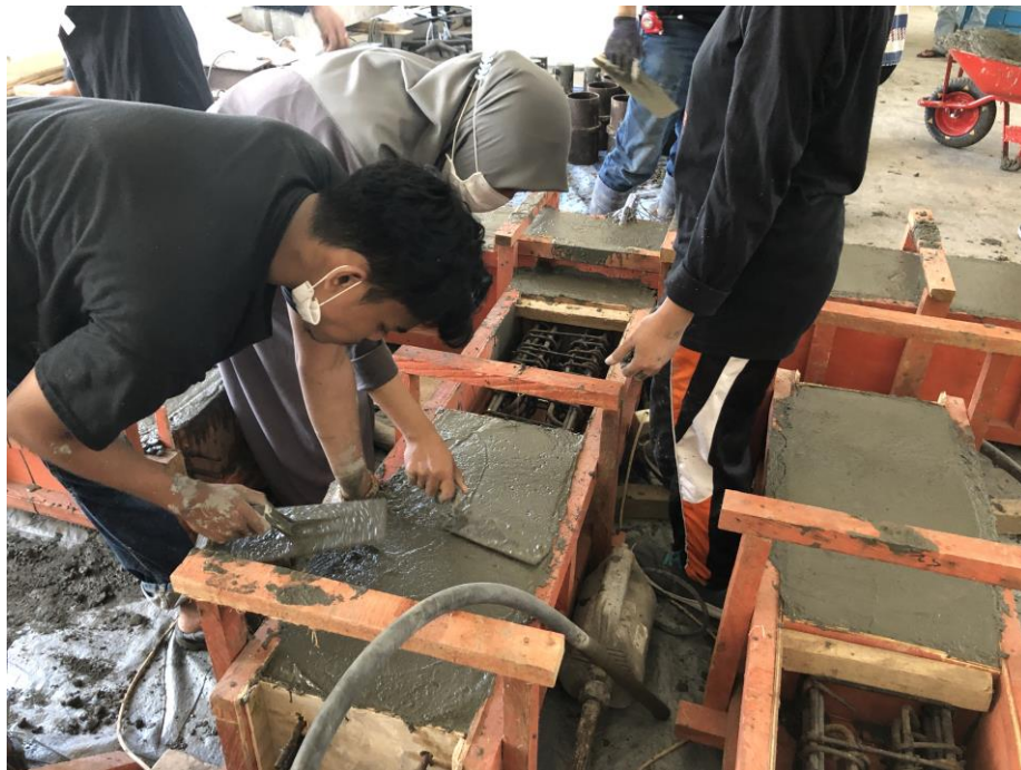
Pengecoran Benda Uji SBK Pracetak 4 Pasak (BG-02)
