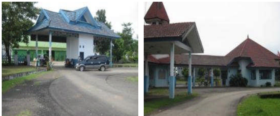
Gambar 10. Kondisi terminal hanya sebagai tempat pembayaran retribusi
