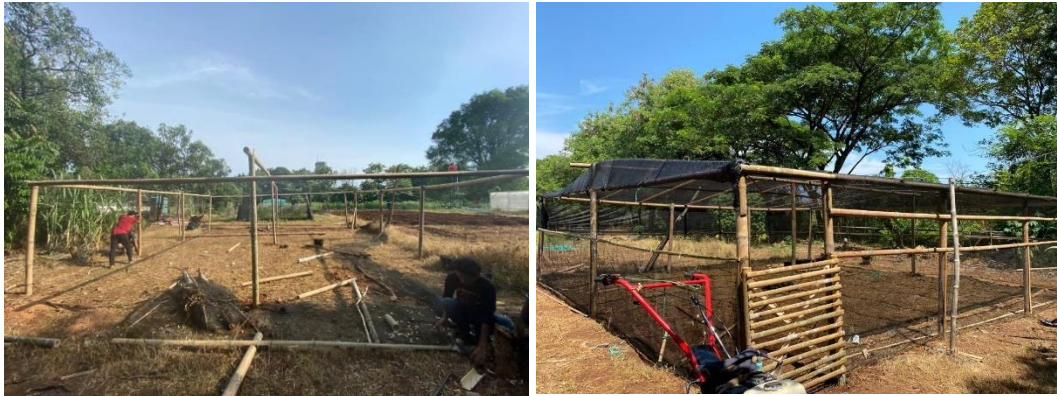
Gambar 2. Membuat Naungan dengan Menggunakan Bambu dan Paranet dengan Tinggi 2 Meter Diatas Permukaan Tanah.
