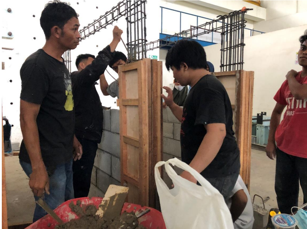
Pengecoran Kolom Benda Uji W1
