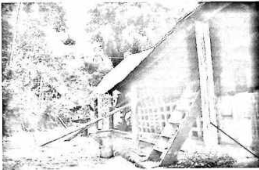
Gambar 6 Tiang penopang ujung atap ( osok pamiring )
