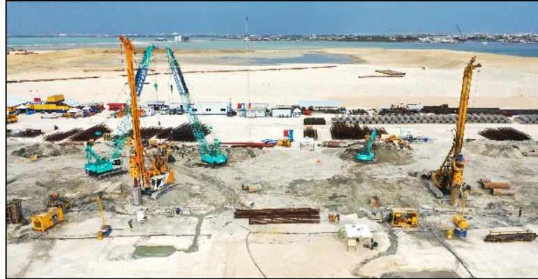
Lingkungan Kerja Proyek Makassar New Port (Gambar diambil menggunakan drone )
