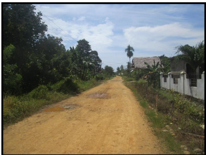
Jalan Tanah di Desa Pompengan Pantai
