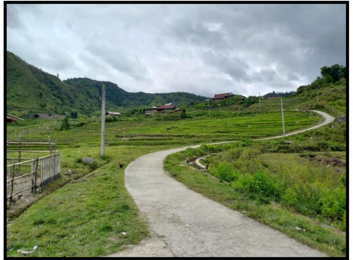
Jalan Rabat yang ada di Desa Marampa
