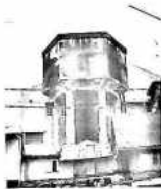
Tower Bantu di JL Tinumbu
