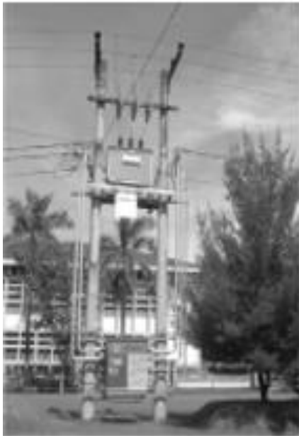
Gambar 2.9 Gardu Tiang Tipe Portal dan Bagan Satu Garis (PLN Buku 4, Standar Konstruksi Gardu Distribusi dan Gardu Hubung Tenaga Listrik, 2010)
