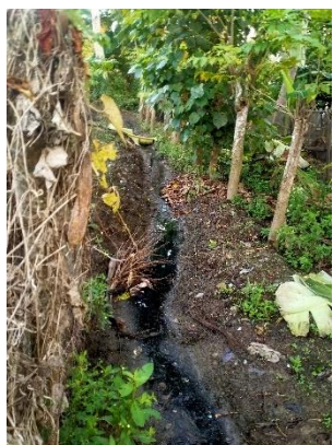
Observasi kondisi selokan
