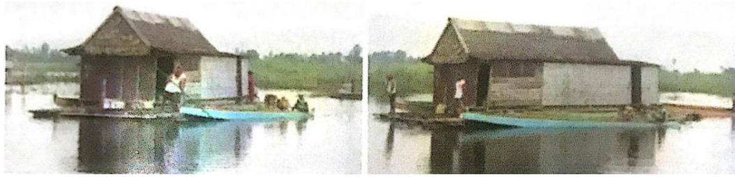
Gambar 7. Cara Memindahkan Rumah Terapung Bola Rai dengan Menggunakan Perahu Motor di Danau Tempe
