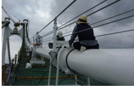
Gambar 2. 4. Kabel Baja pada Struktur Gantung Sumber : id.scribd.com
