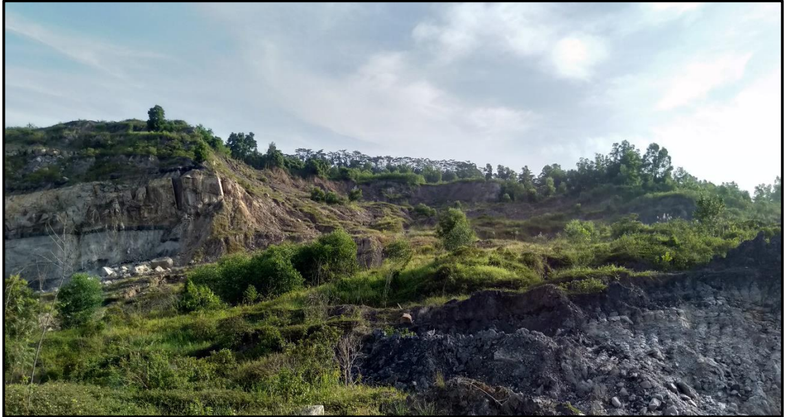
Kondisi lereng sidewall utara
