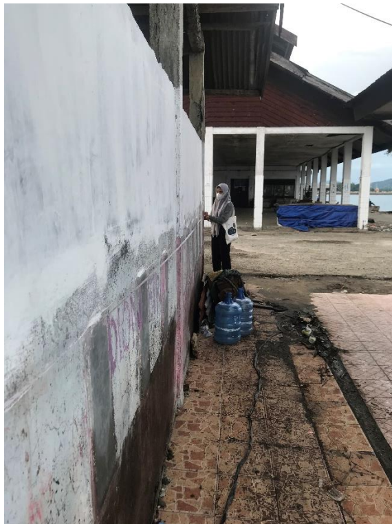
Pengukuran Fasilitas Pelabuhan PPI Pontap
