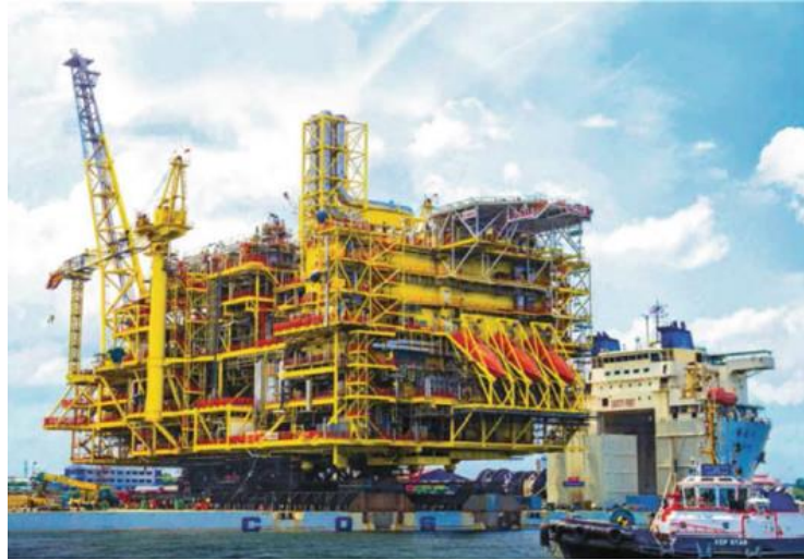
Gambar 2. 10 Integrated topsides untuk instalasi floatover di Malaysia (Proyek KBB) (Sumber: KPOC)
