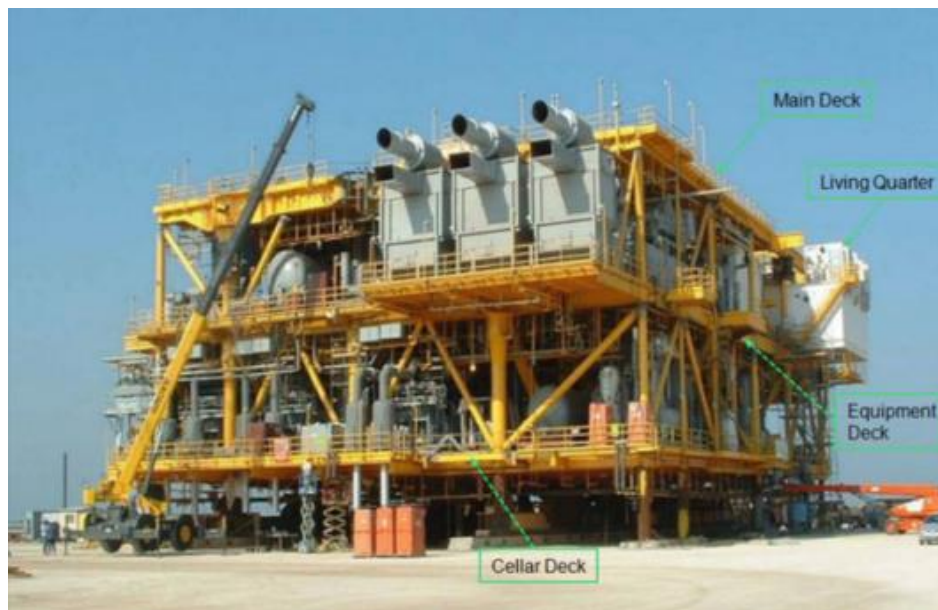
Gambar 2. 8 Topside dengan multi-level deck yang terdiri dari modul (Sumber: Anadarko Petroleum Corporation)
