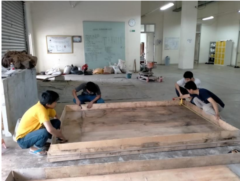
Proses Pembuatan Bekisting Pelat
