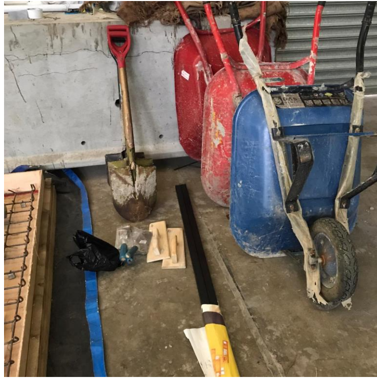
Persiapan Alat Pengecoran
