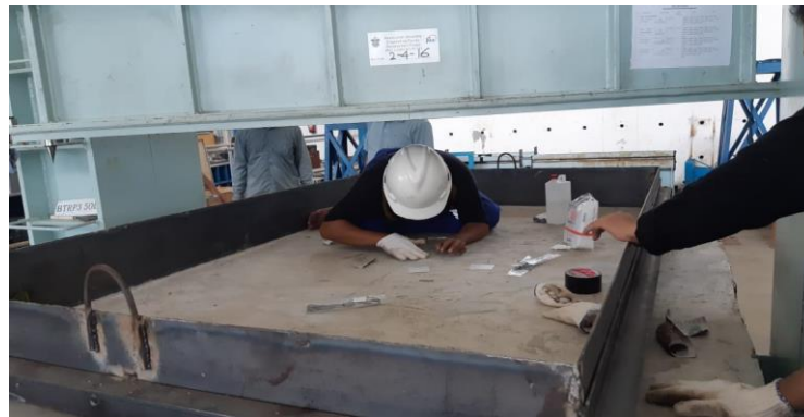
Pemasangan Strain Gauge Beton
