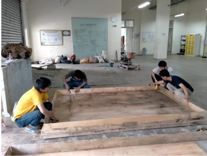
Proses Pembuatan Bekisting Pelat
