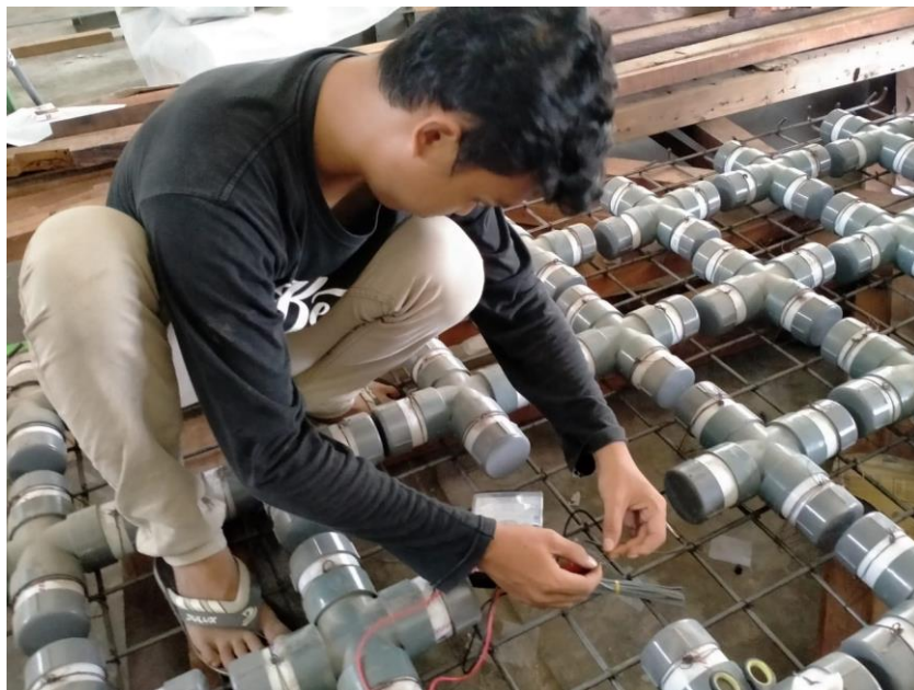
Pemasangan Starin Gauge Baja Pelat Berongga
