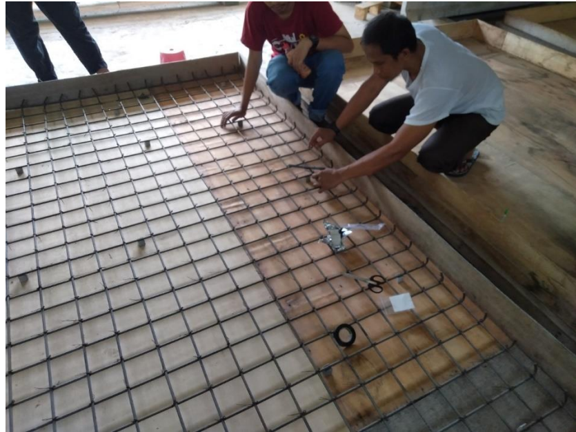
Pemasang Strain Gauge Baja Pelat Pejal
