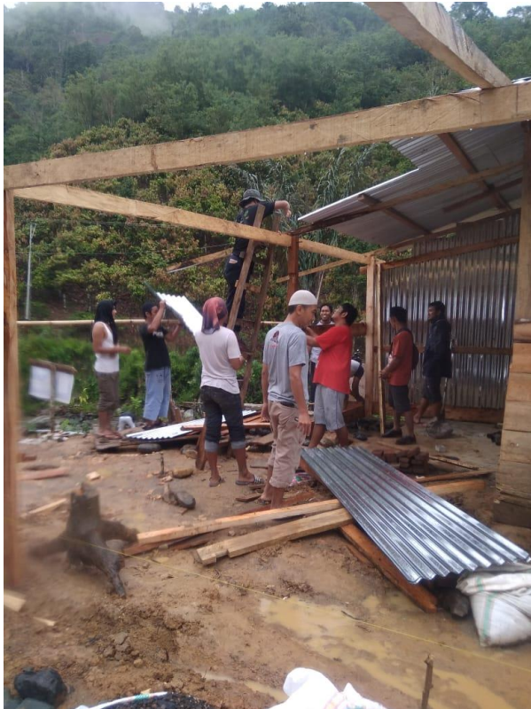
Gambar 4: Proses Membangun Masjid
