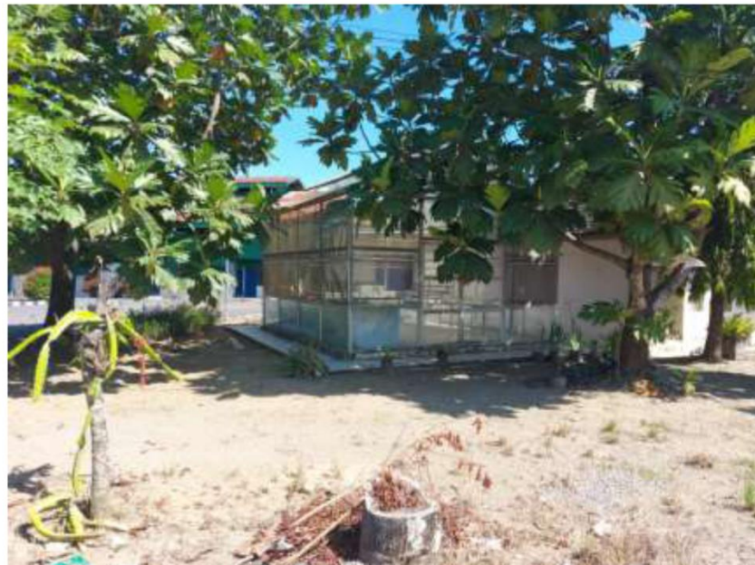
Sarana dan Prasarana PT. SHS (Persero) Cabang Sidrap di Sidrap
