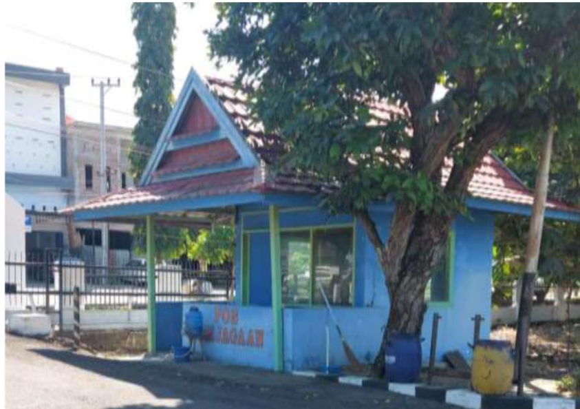
Sarana dan Prasarana PT. SHS (Persero) Cabang Sidrap di Sidrap
