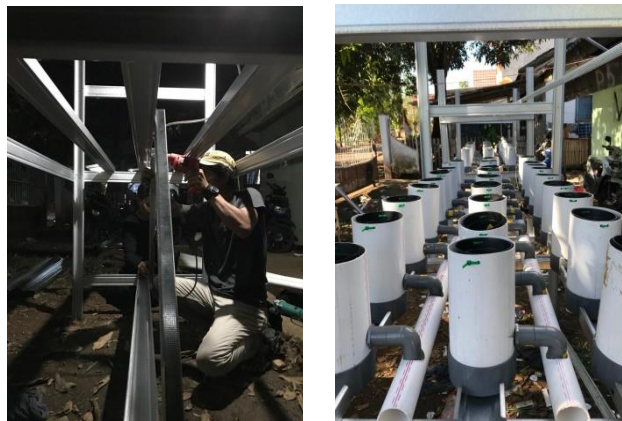
Lampiran Gambar 3. (a) Proses Perakitan Instalasi Irigasi Tetes, (b) Instalasi Irigasi Tetes
