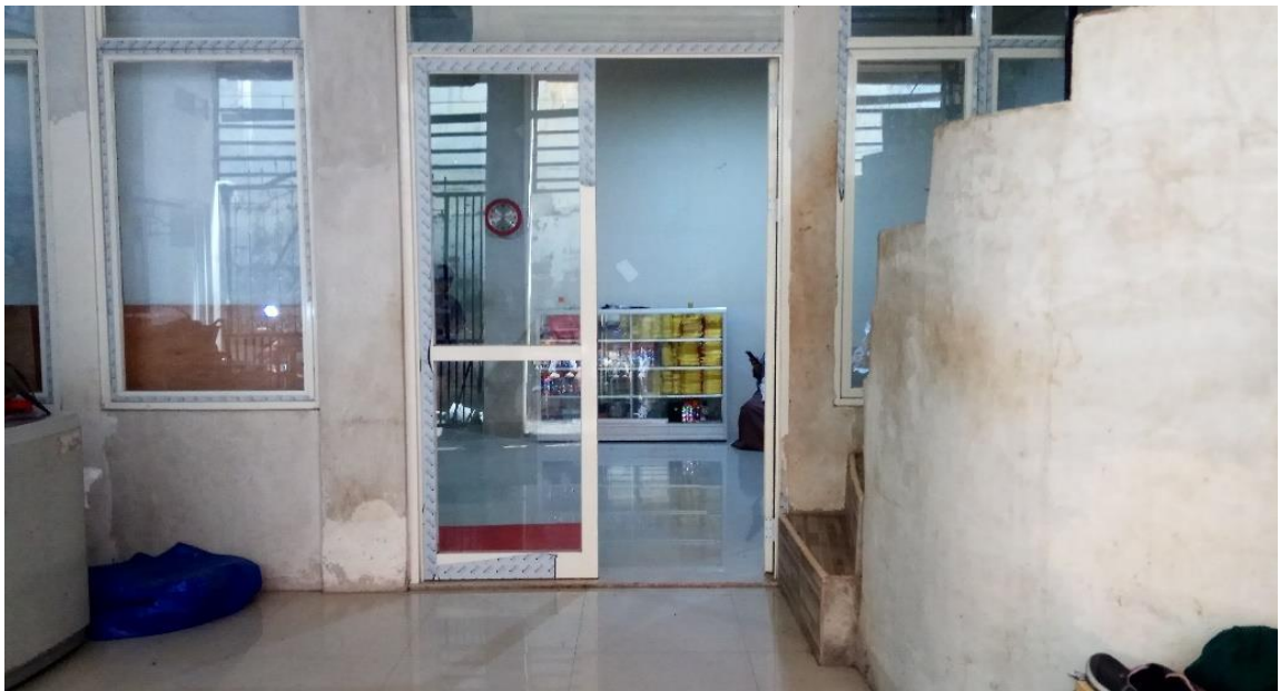
Kondisi jendela, pintu, dan ventilasi
