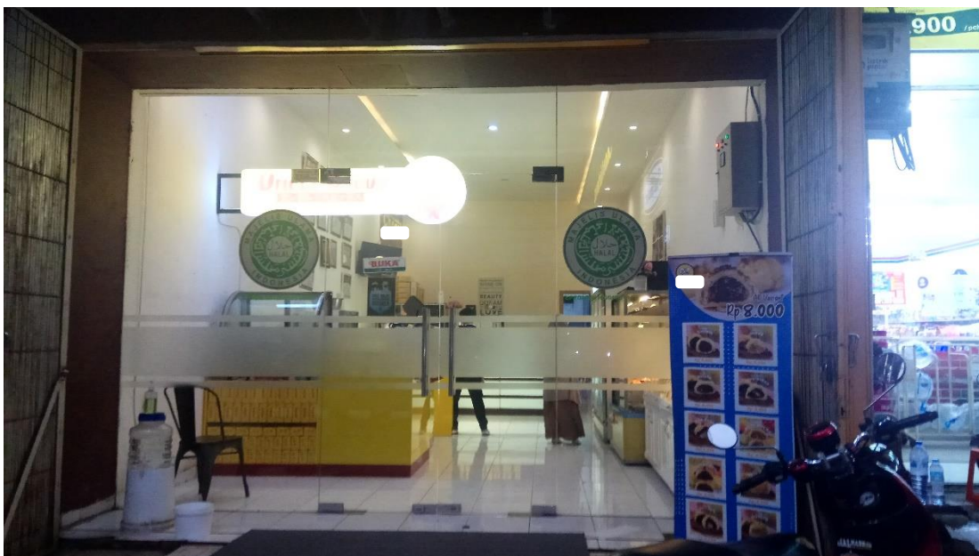
Tampak pintu dan ventilasi dari luar
