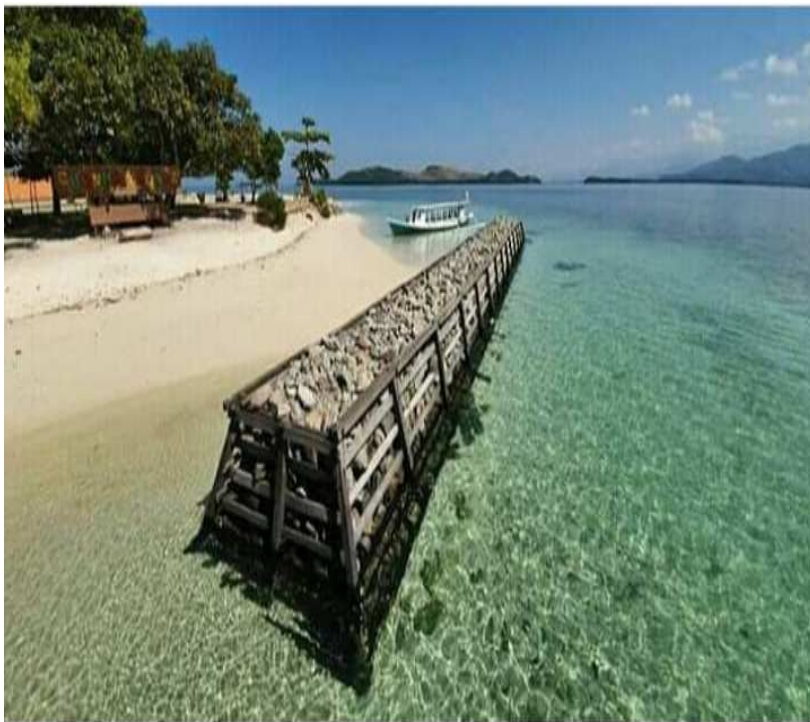
Pemecah Ombak Pulau Gusung Toraja
