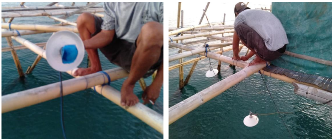
Proses pemasangan lampu
