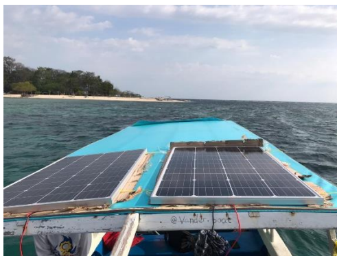
Pemasangan Panel Surya
