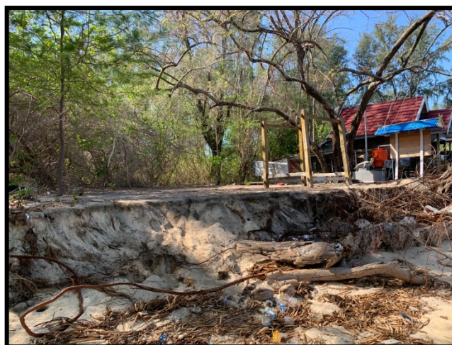
Gambar 16. Kondisi Abrasi Pada Stasiun II
