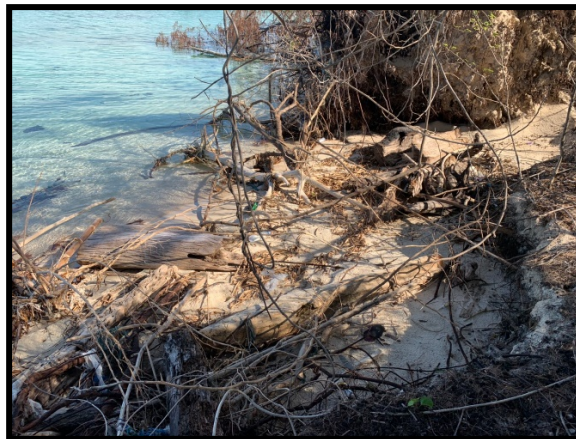
Gambar 15. Kondisi Abrasi Pada Stasiun I
