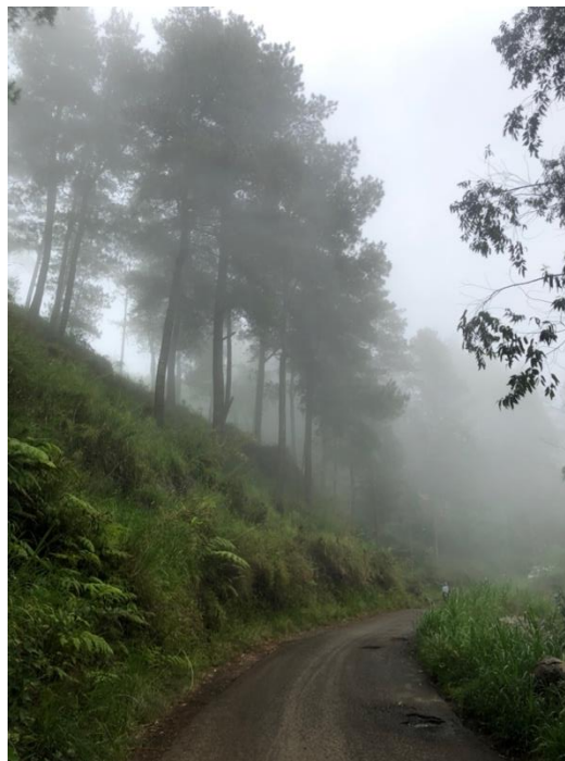
Ket: Kondisi jalan Dusun Langkoa
