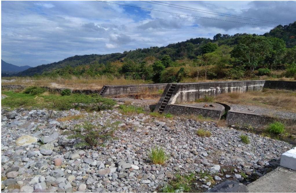
Kondisi Sabo DAM DAS Jeneberang
