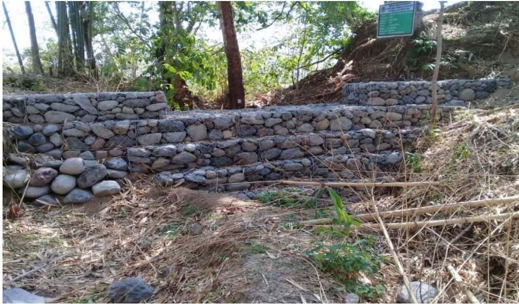
Kegiatan Konservasi Tanah dan Air Pembuatan DAM Penahan Di Kecamatan Parigi
