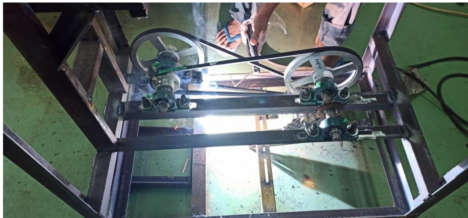
Gambar 8 Pemasangan Komponen Alat
