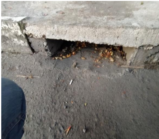
Drainase yang berfungsi mengalirkan air dari jalan ke dalam waterpond yang telah diperbaiki / diperluas
