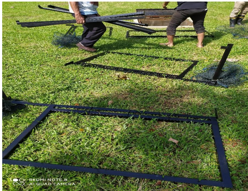
Pemasangan Jaring penampung sampah di dalam waterpond
