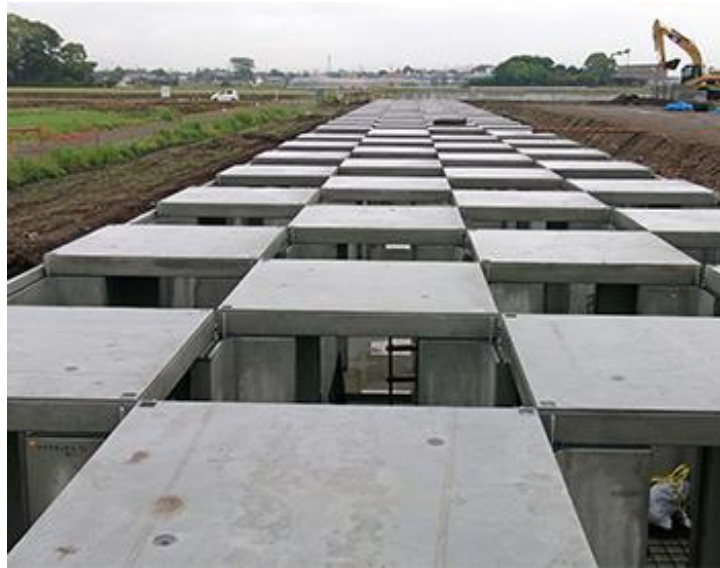
Pemasangan beton precast kolam penampungan air hujan ( waterpond )
