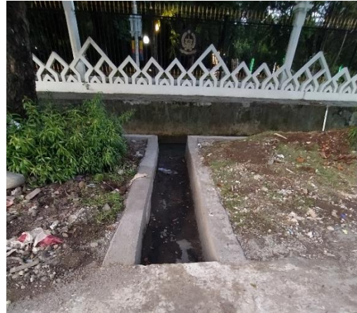
Drainase yang berfungsi mengalirkan air dari jalan ke dalam waterpond yang telah diperbaiki / diperluas
