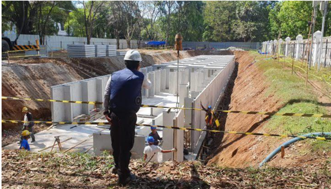
Pemasangan beton precast kolam penampungan air hujan ( waterpond )
