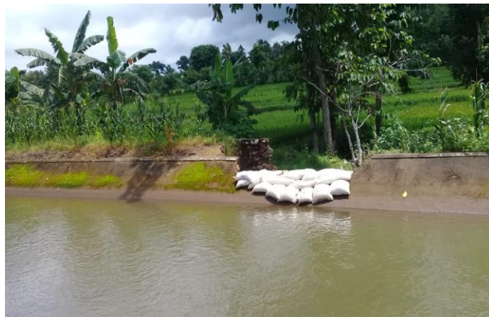
Gambar L-1. Saluran yang bobol
