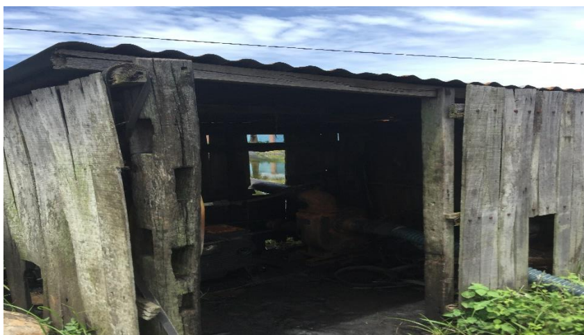
Foto penyimpanan mesin pompa air
