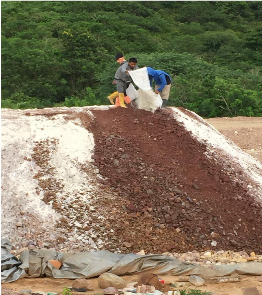
Gambar 18. Proses Pengelolaan Pertambangan Penyiraman dengan Kapur
