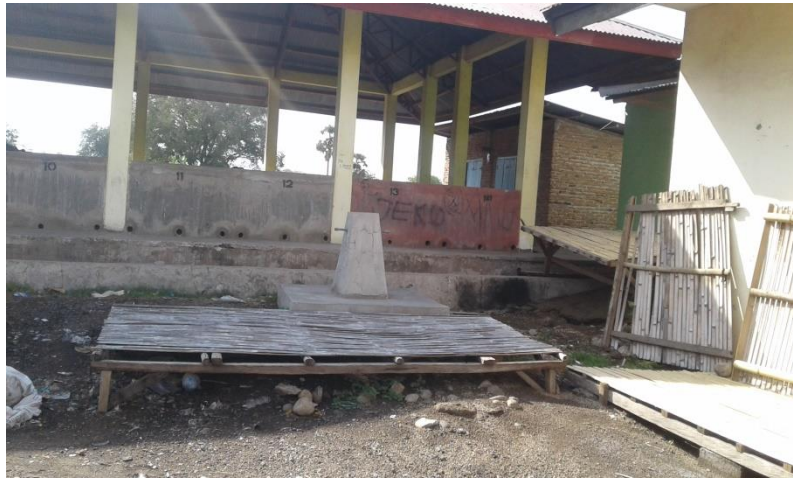
Bangunan untuk menjual ikan kering
