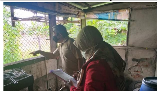
Observasi kondisi SPAL
