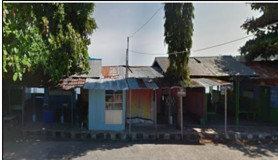
Observasi kondisi bangunan
