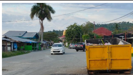
Observasi kondisi bangunan
