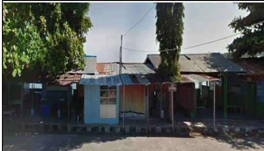
Observasi kondisi bangunan
