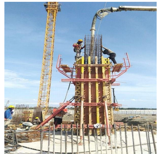
Pekerjaan Pengecoran
