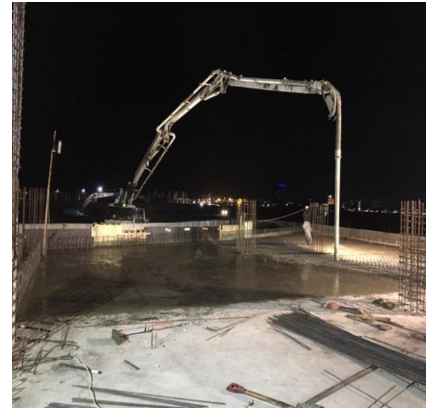
Pekerjaan Pengecoran
