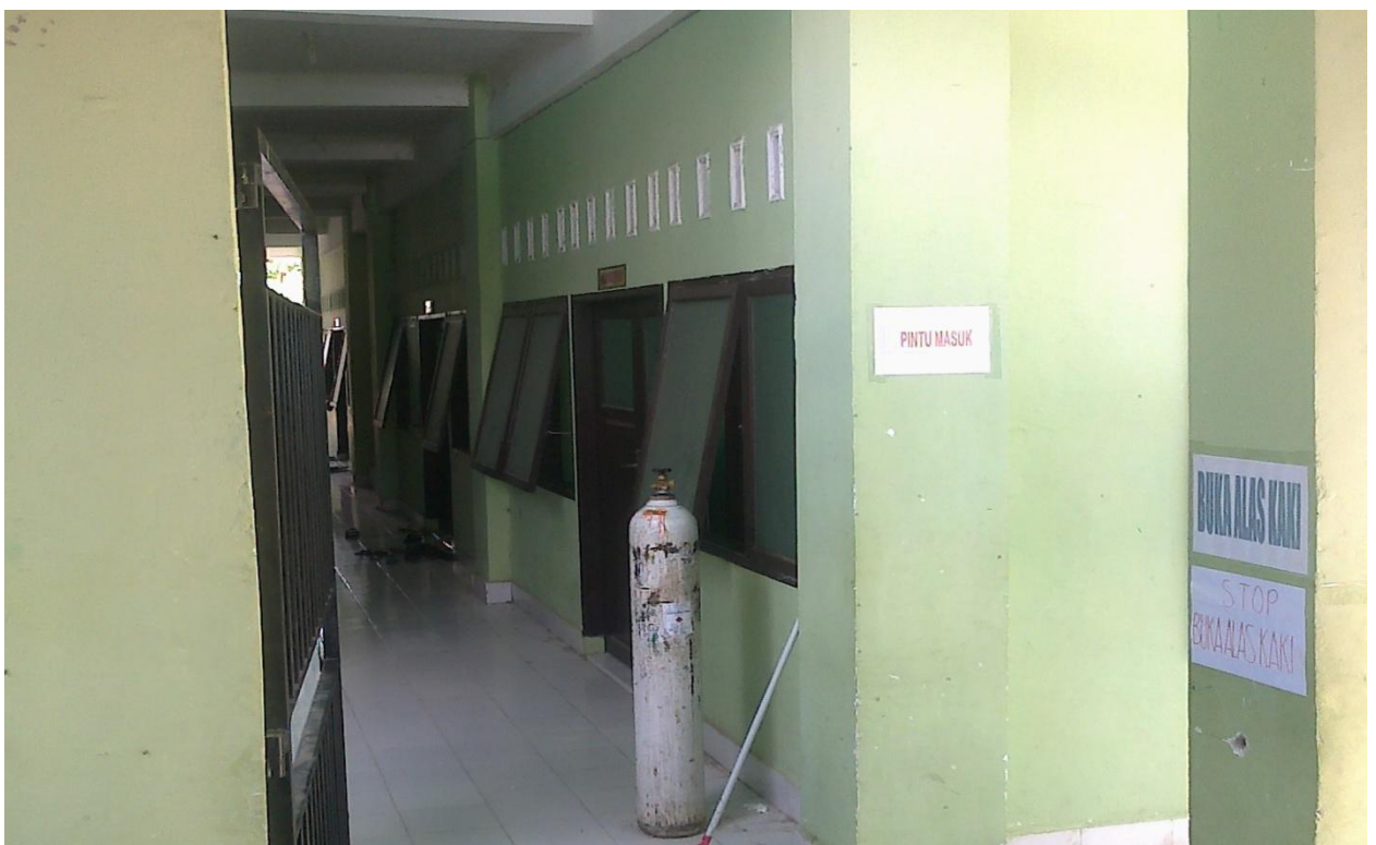
Gambar 5. Tampak dari luar Ruang Perawatan kelas III bagi pasien layanan kesehatan gratis pada RSUD Andi Makkasau Kota Parepare
