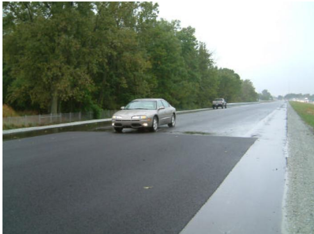
Gambar 2.12 Perbedaan penggunaan aspal porous dan aspal padat
