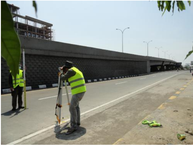
Foto.01 Pengukuran Elevasi Zona Oprit Barat (Depan Gedung Graha Pena )
