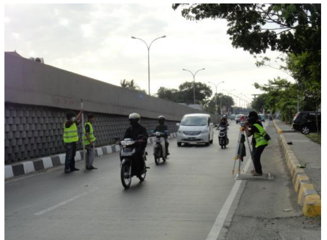
Foto.04 Pengukuran Elevasi Zona Oprit Timur (Depan Gedung DPRD)
