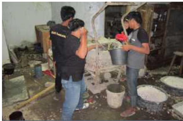
Proses penuangan bahan penyusun beton kedalam molen
