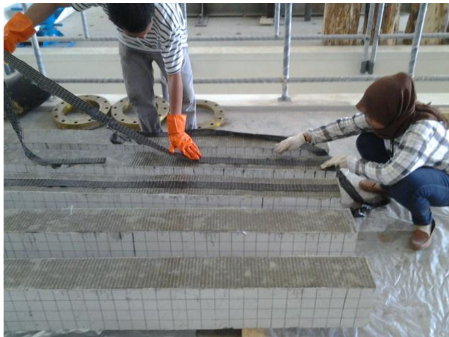
Pemasangan CFRP
