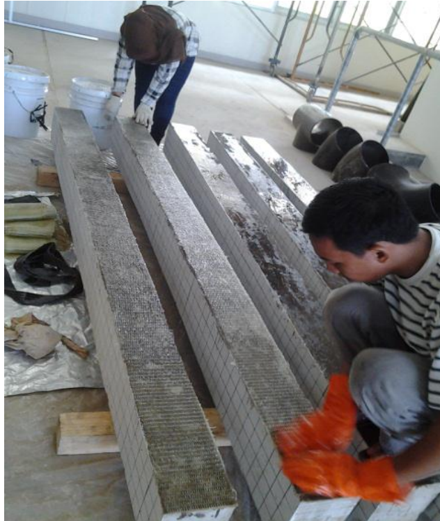
Pemasangan GFRP
