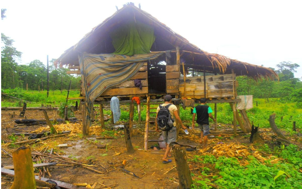
Gambar 6. Dinding rumah yang tidak rapat di dusun I Desa Awiu Kecamatan Lambandia Tahun 2013
